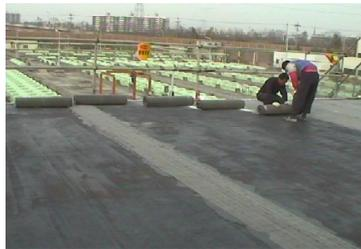
Vollflächiges Aufgießen der **Bauder** PYE- PV 200 DD
