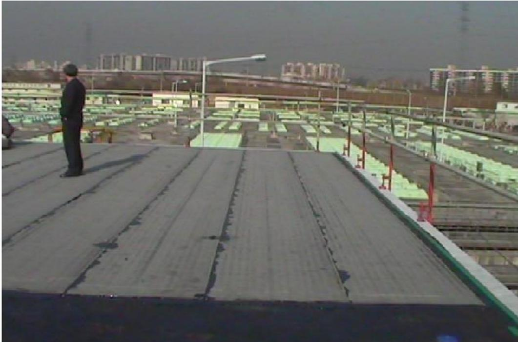
Auf einer Fläche von ca. 200.000 m<sup>2</sup> wird z. Zt. in Seoul (Süd- Korea) eine **nichtunterläufige WIROBIT-Kautschukbitumen-Abdichtung** mit **Bauder Polymerbitumenbahnen** hergestellt.
